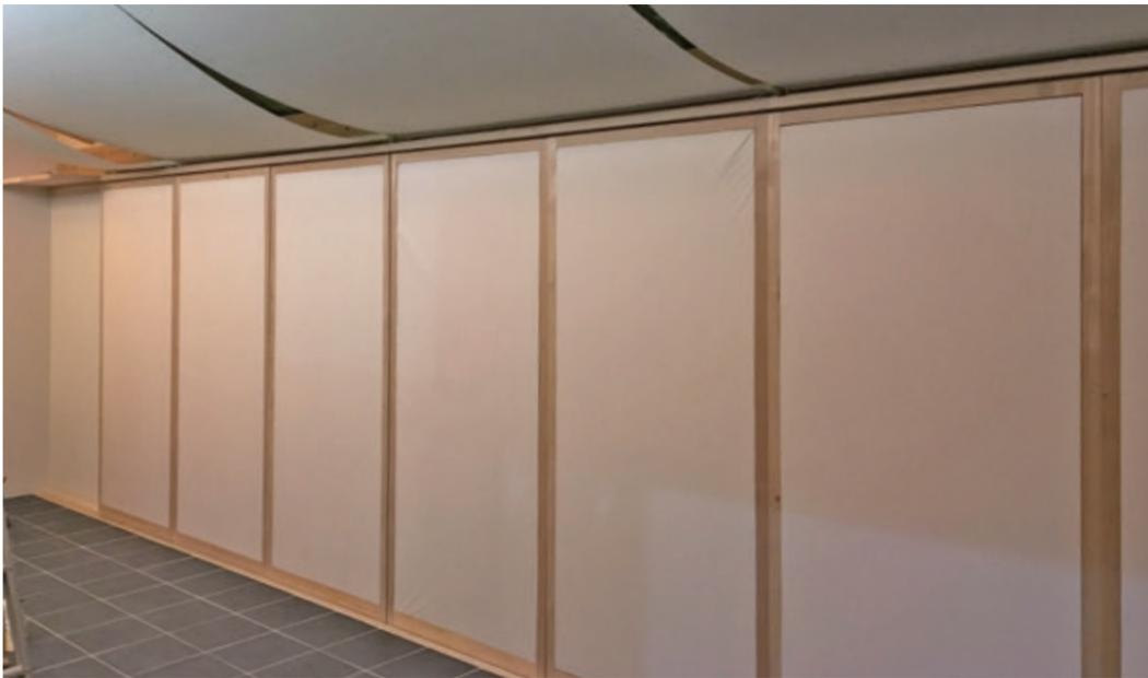
南北のガラスの窓の内側に断熱建具（引き戸）を設けました。40mmの断熱材（ポリスチレンフォーム）を障子で覆っています。日射熱取得のなくなる夕方以降、外気温度の下がる夜間の熱損失を抑えて、室内の温度低下を防ぎます。建具の熱抵抗は  $1.0\text{m}^2\text{K/W}$ （窓と合わせた、U値は  $0.68\text{W/m}^2\text{K}$ ）となります。
