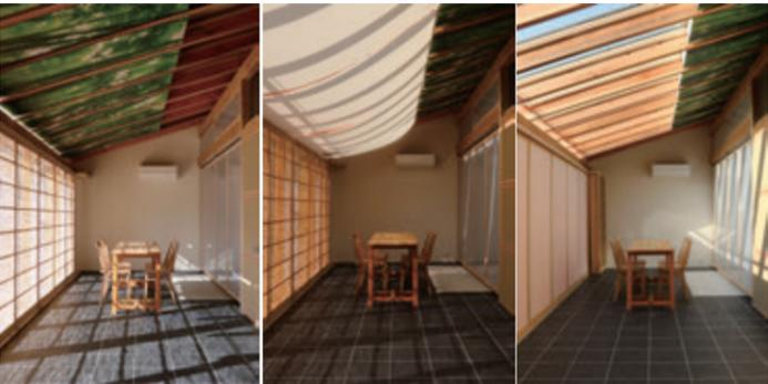
**夏季** 可動式断熱建具で強い日差しを遮り、通風建具によって換気を促します。
