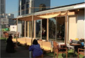
夏の日射遮蔽のため、日中は可動式断熱建具を閉じます。また、南側のガラスの底からの日射を遮蔽するために、底下にすだれを設けます。
