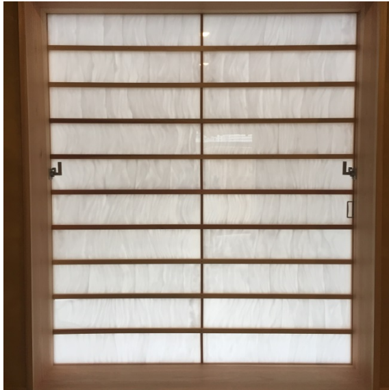
エアロゲル建具 熱貫流率 1.26 [W/m^2K]
