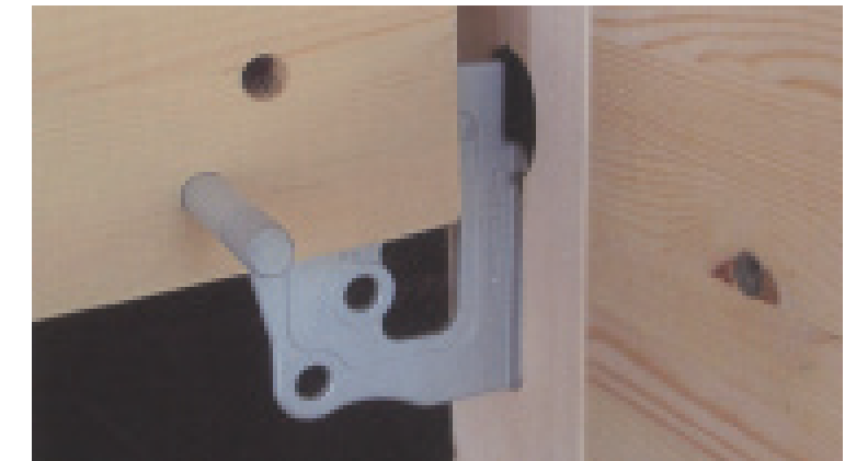
パワービルド工法接合金物
