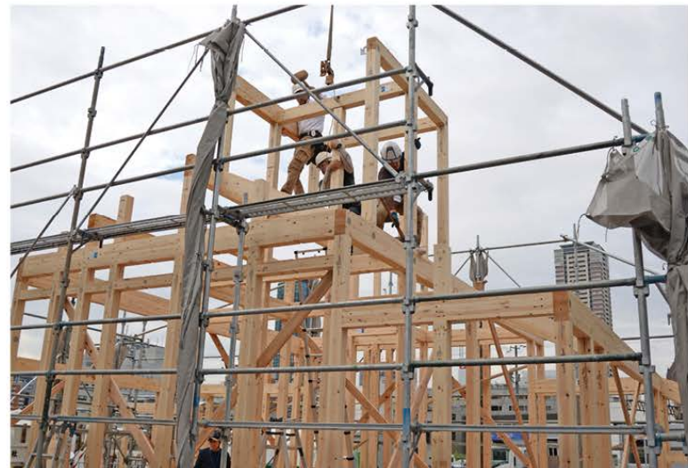
軸組の施工風景
